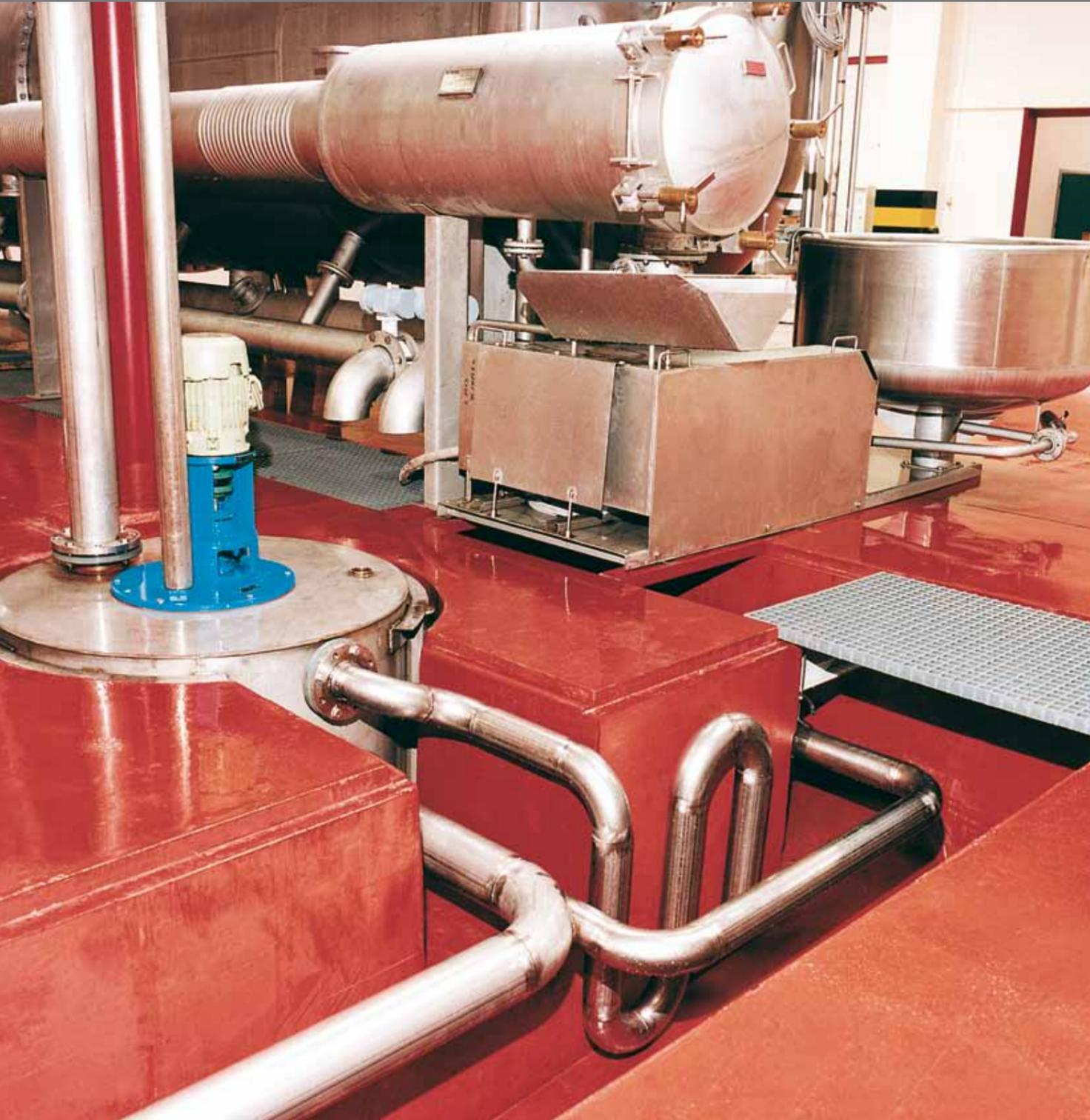
La tintoria di Fruit of the Le canaline sono interamente rivestite di UCRETE®, eliminando così la necessità di creare i giunti solitamente connessi alle canaline e prolungando la durata della pavimentazione.
